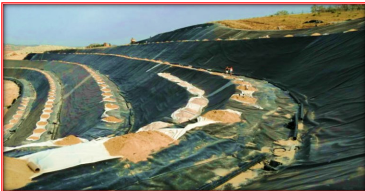
Figura 4: IMPERMEABILIZZAZIONE DELLA VASCA DI COLTIVAZIONE
