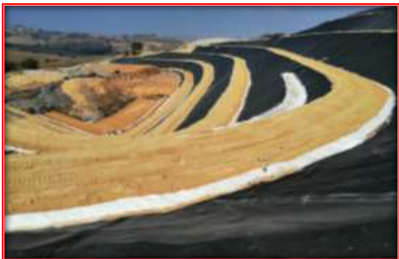
Figura 5: COMPLETAMENTO DEI LAVORI
