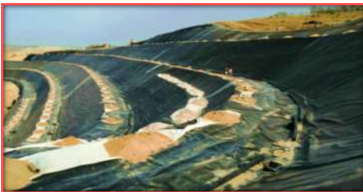
Figura 4: IMPERMEABILIZZAZIONE DELLA VASCA DI COLTIVAZIONE
